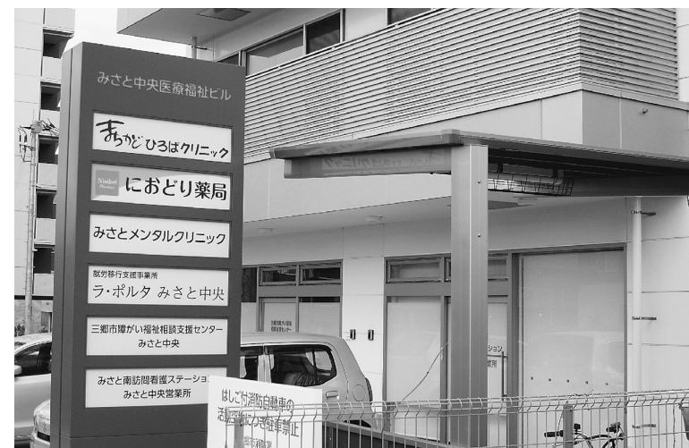
みさと中央医療福祉ビル外観
