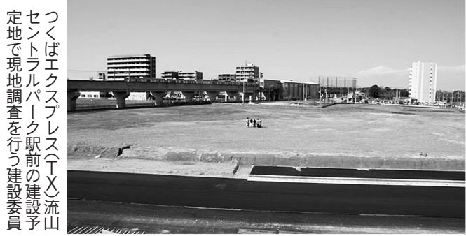
つくばエクスプレス(TX)流山セントラルパーク駅前の建設予定地で現地調査を行う建設委員
